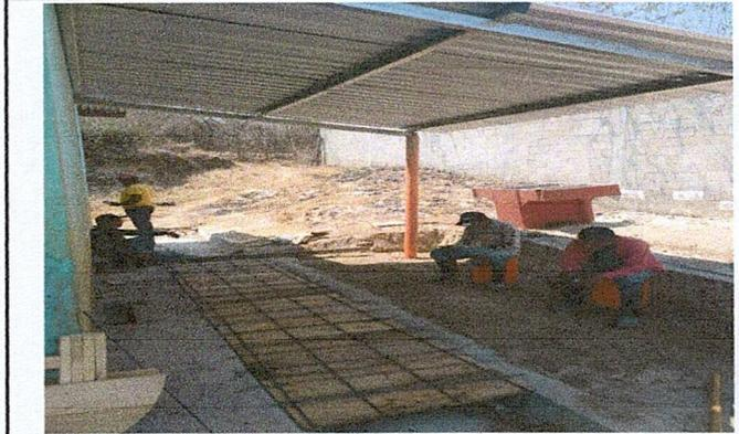
Foto 2 : Fundición con drenaje para la plancha y colocación de la pila para estación de lavado de manos.
