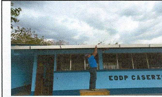
Foto 4: Instalación de canales para la recepción de agua pluvial, en los módulos de preprimaria.
