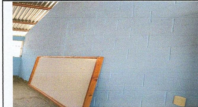
Foto 6: Remoción de pintura en el interior de los módulos de preprimaria.
